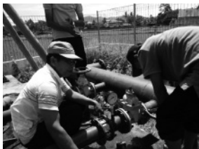
取水設備の運用改善実習
