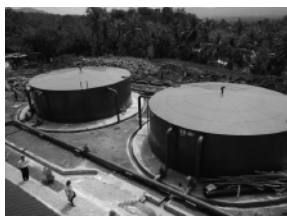
配水設備（配水池）
