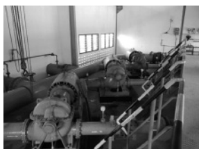
配水ポンプ設備
