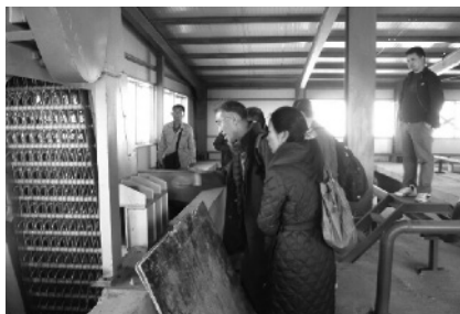
写真-11 現地視察・技術指導（新下水処理場）
