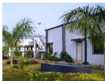
エントランス周辺
