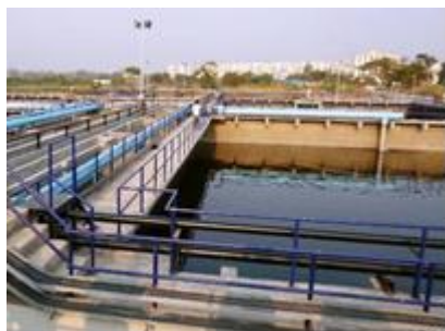
回分槽（処理槽）
