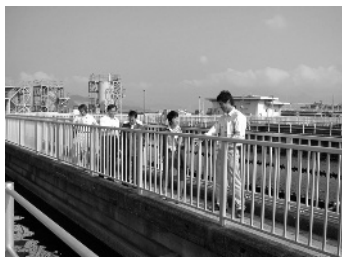
日明浄化センター
