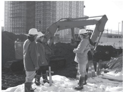
寒冷地における冬期施工技術を視察
