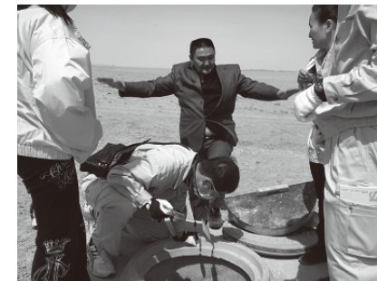
写真-7: 送水管(上水)の施工状況
