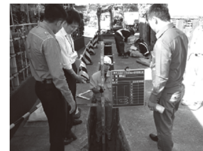
写真-2：配管工事施工管理の研修
