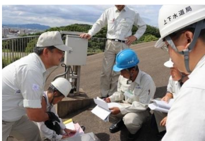
配水池の点検
