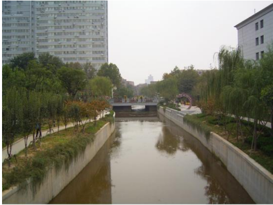
猪龍河緑地整備済み区間
