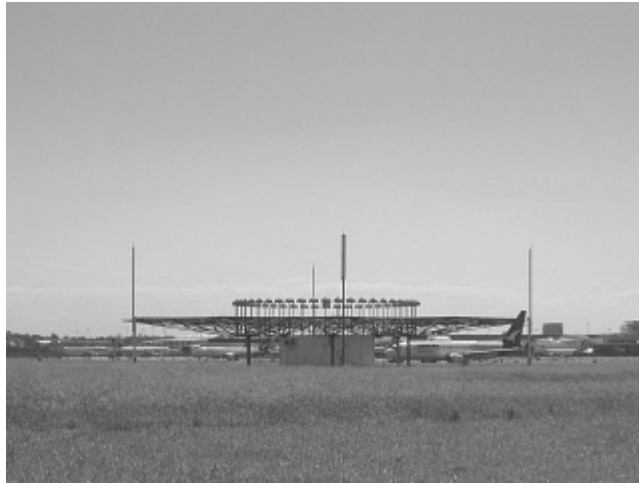
シドニー国際空港に設置されている VOR (112.1MHz の電波で運用されている)
