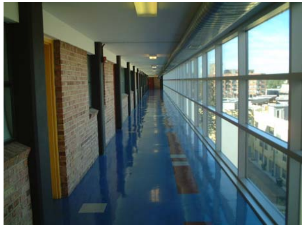
第 1 期プロジェクトにより修復された住宅：廊下にはガラスの壁が張られ、外気にさらされることがなくなった
