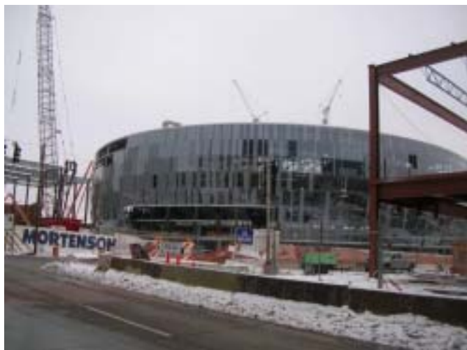
建設中のスプリントセンター
