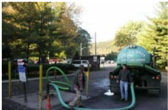
ホーソン汚泥投入場
