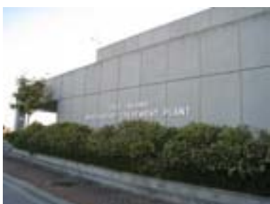
ルル島下水処理場
