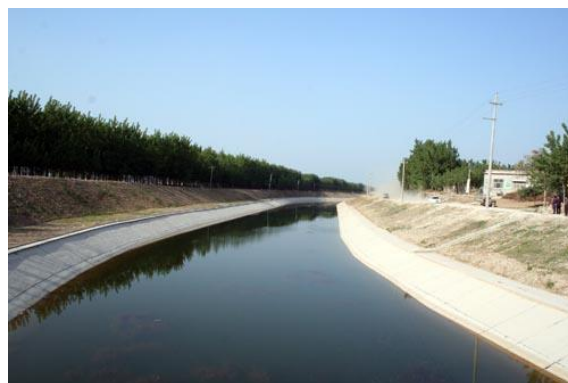
写真 南水北調事業により完成した水路（山東省） （資料）南水北調網より
