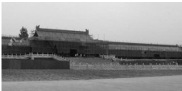
↑修復が続く故宮博物館。五輪に向け、現在多くの文化財の改修・修復が進められている
