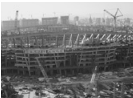
↑建設が進む国家体育场
