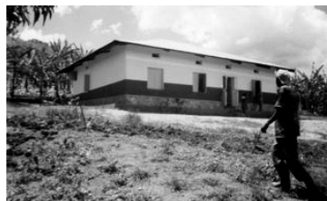
↑ (完成された) ヘルスケアセンター
