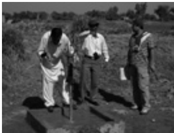
↑パキスタンサイクロン (手動ポンプ設置)
