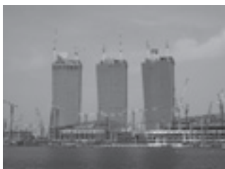
↑ カジノの建設現場。山のようにビルが林立しています（マリナナ・ベイ地区）
