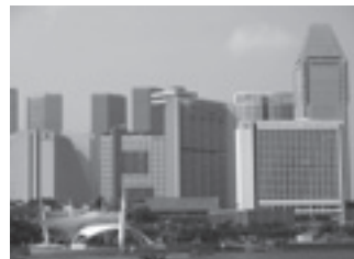
↑風水を取り入れたホテル群 (マリナー・ベイ地区)
