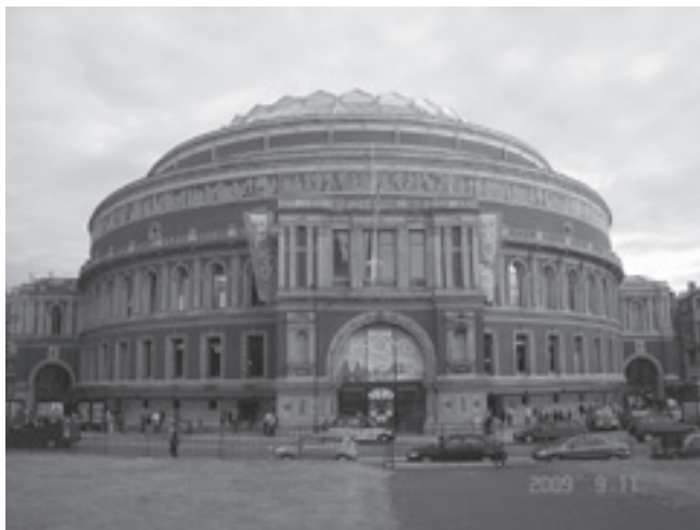
↑ロイヤル・アルバート・ホール
