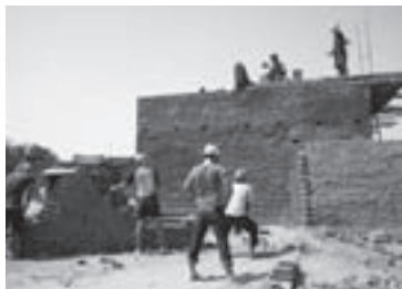
建設重機がないためひとつずつレンガを上階に投げて上げた
