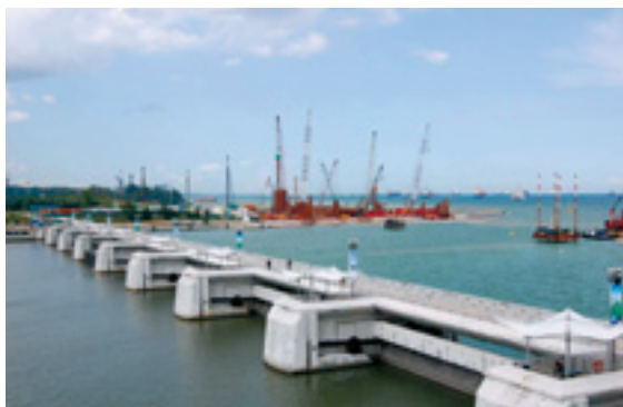
マリナー・バラージ。河口に堰を設け、海水を淡水化するための施設です。一般に公開されており、見学することができます。
