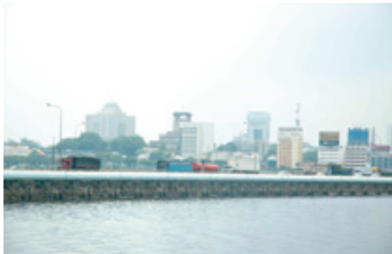
マレーシアから水を輸入するための送水管
