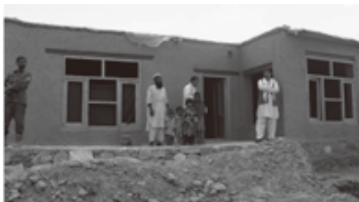
アフガニスタン 難民キャンプ地区の住宅・トイレ建設 写真提供：国連ハビタット
