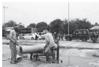
進む公共工事
