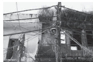
複数の電線が伸びる電柱
