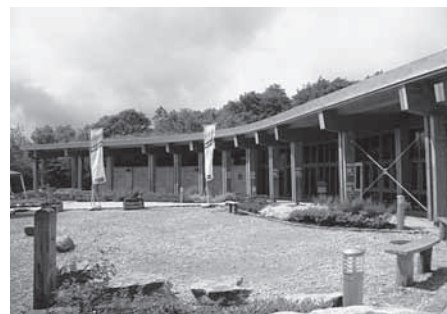
ダービーシャー・エコ・センター施設
