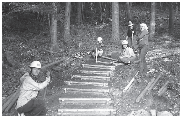
福岡県：3か月で300mの遊歩道が完成!
