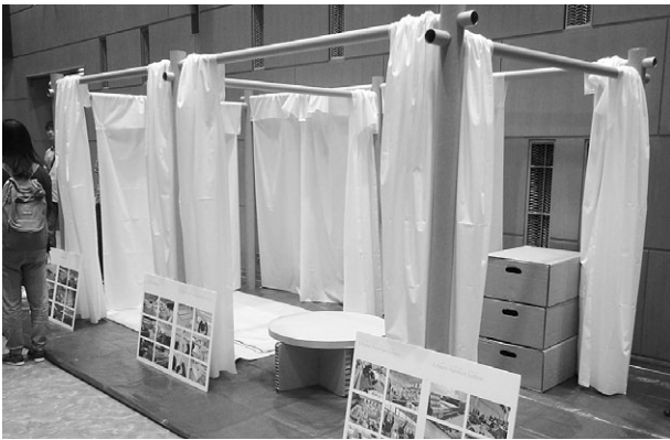
「紙管」を使った簡易間仕切りの設置
