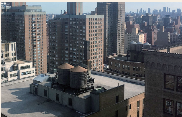
高層ビルの屋上にある貯水タンク
