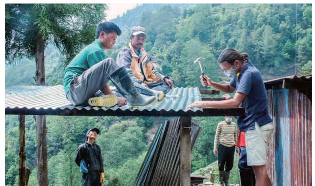
仮設シェルターの建設を進めるネパールの住民
