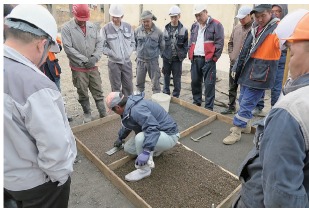
モンゴルで実施した石炭灰を再利用した舗装技術の実演
