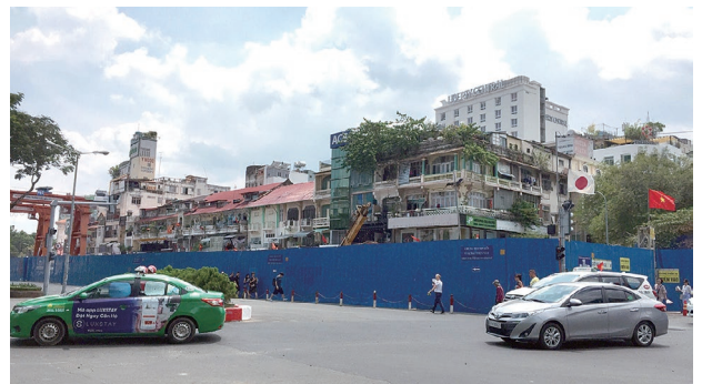
日の丸がはためくホーチミンの地下鉄工事（2020年完成予定）
