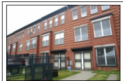
サイト A に建設された 分譲タウンハウス
