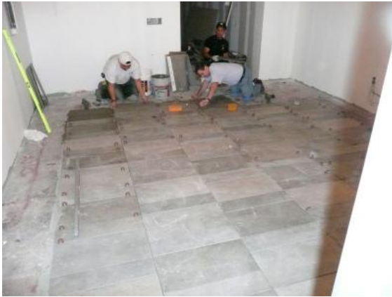
エントランスホール床の石張り
