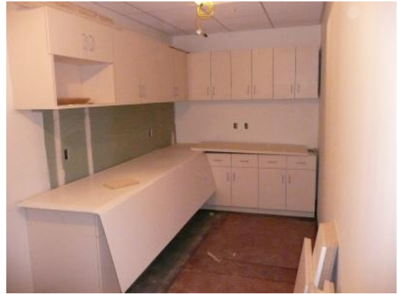
給湯室の家具設置完了
