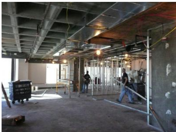
間仕切壁の下地（軽量鉄骨 LGS）の組み立て及び天井の空調配管の設置
