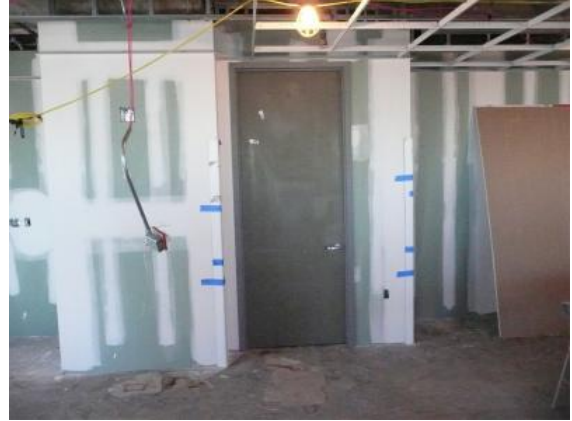
鉄製扉の取り付け
