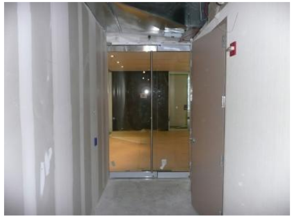
エントランス扉の設置
