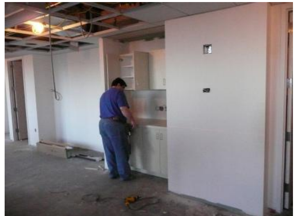
事務室の家具設置
