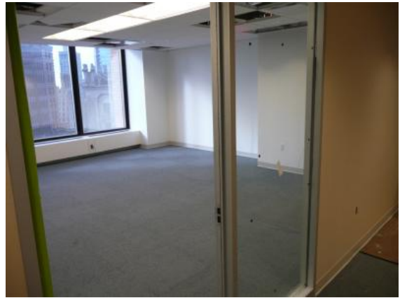
建具のガラス取り付け
