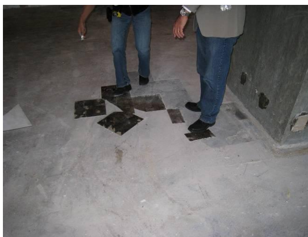
疑わしい床のビニルタイルあるいは接着剤
