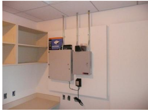
コピー・サーバー室の電気配管
