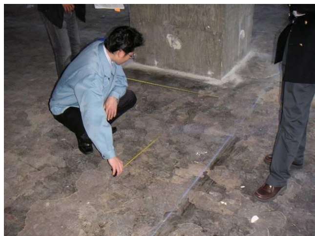
墨出し後の確認の様子
