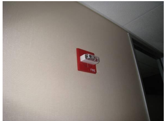
Fire Alarm(火災報知器) スピーカーとフラッシュライトが内蔵されている
