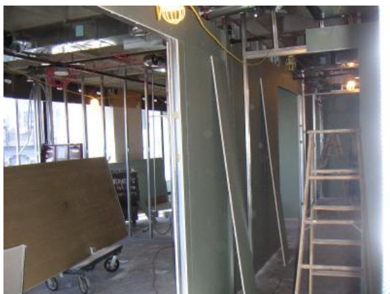
間仕切壁の下地にプラスター（石膏）ボード貼り付け
