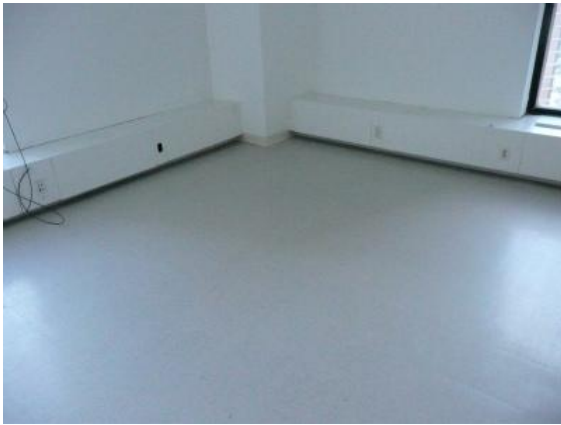
図書室床のビニルタイル張り
