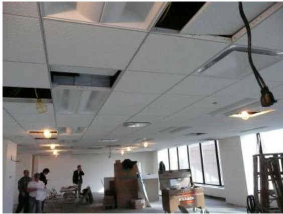
システム天井の仕上げ
