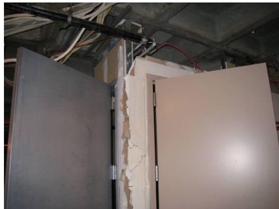
2. 機械室との不完全な壁
