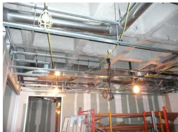
天井下地（軽量鉄骨 LGS）の組み立て
