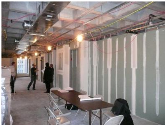
塗装下地のパテ塗り（石膏ボードの白い線の部分で、凹凸をなくす下処理）
