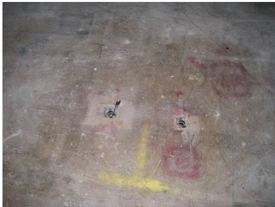
1. 床の設備配線用の穴
