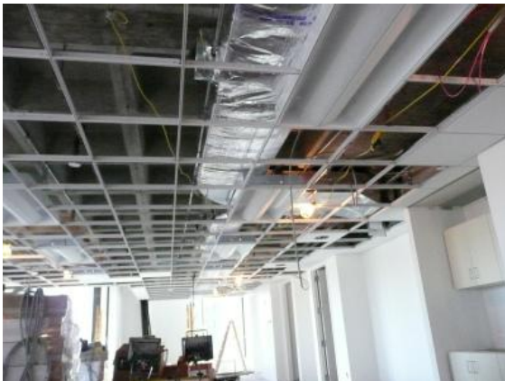
システム天井枠に照明器具設置
