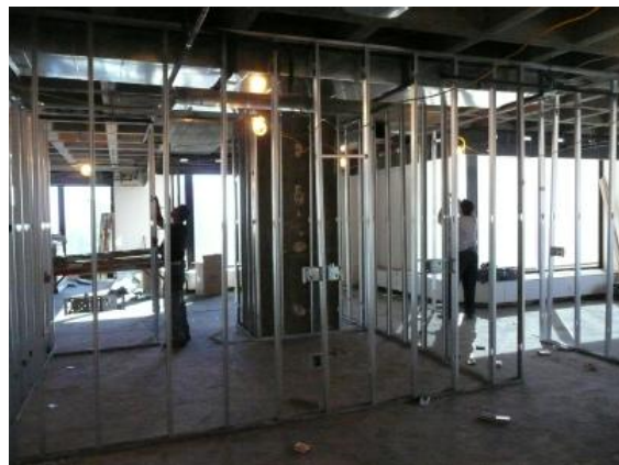
スイッチや電源アウトレットのボックス（間仕切壁内に埋め込み）も取り付けられている
