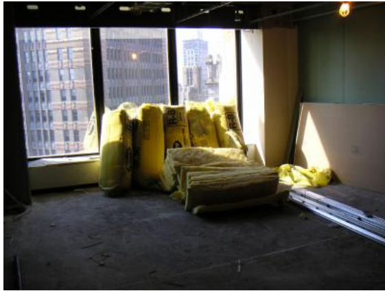
間仕切壁内に設置される断熱材
