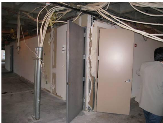
3. 通信データ配線用の鋼管
