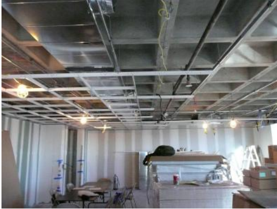
システム天井 136 枠の設置
