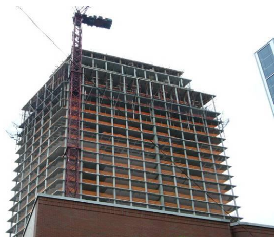
ニューヨーク市内で建設中のビル
