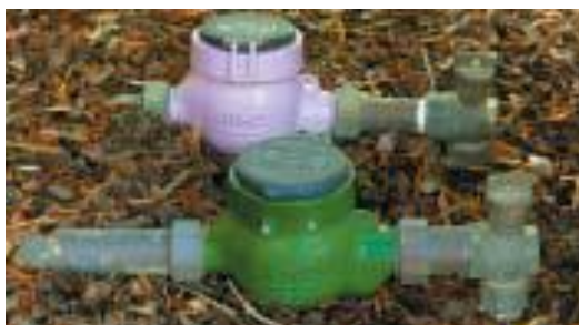
水道メーターは水道水用とリサイクル水用がそれぞれ備え付けられている
