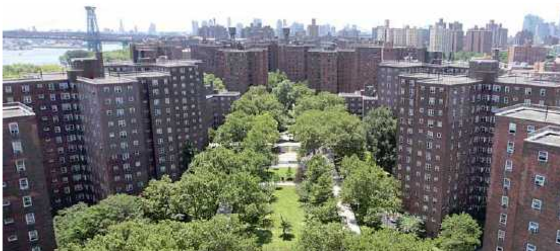
ニューヨーク市マンハッタン（イーストビレッジ）に1949年に建設された公営住宅
