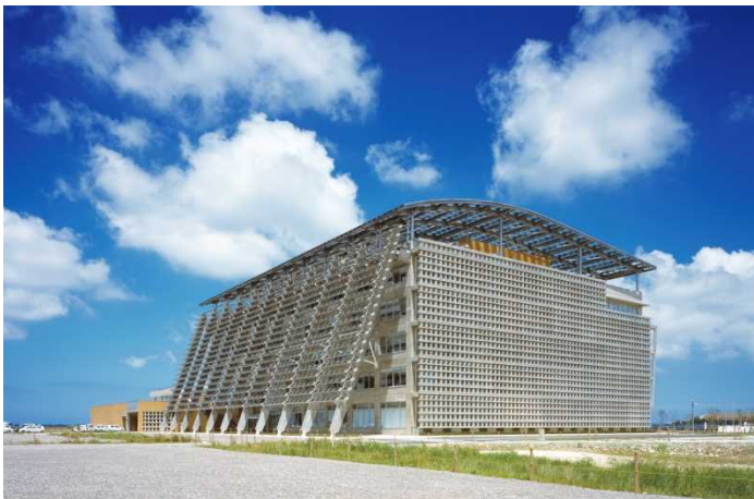
Hôtel de ville équipé d'un système de génération solaire sur le toit (Itoman, département d'Okinawa)
