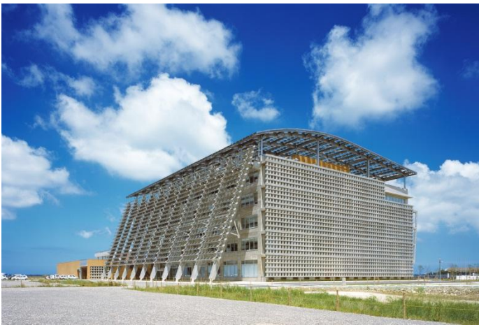
在南面及屋顶设置太阳能发电系统的市政厅建筑物 冲绳县丝满市
