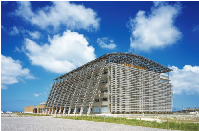
Hôtel de ville équipé d'un système de génération solaire sur le toit (Itoman, département de Okinawa)
