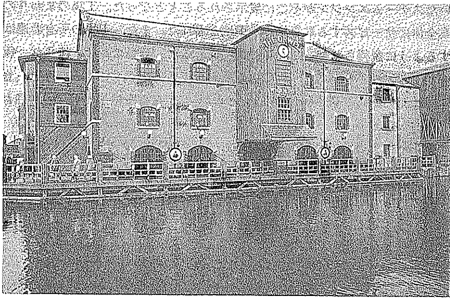
図10. 郷土資料館となった倉庫
