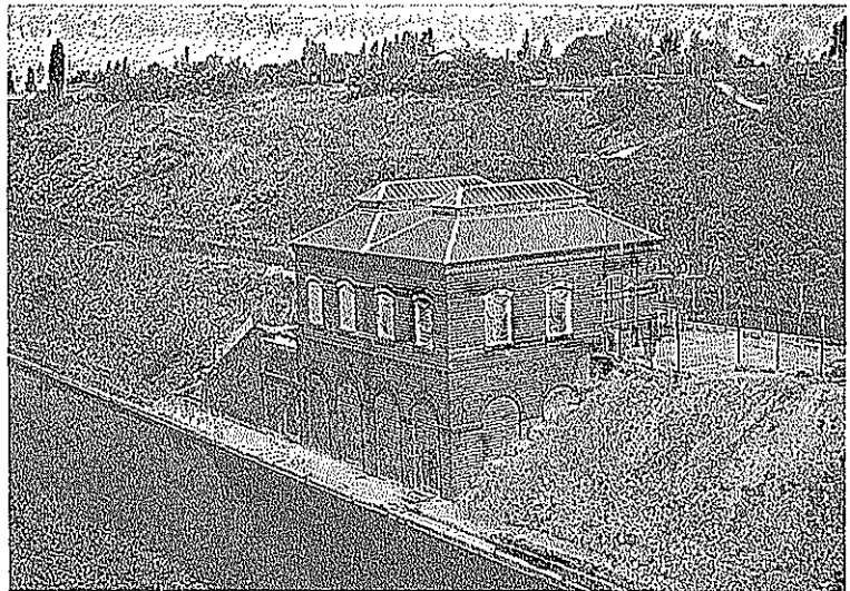
図17. 修復された、ガルトン・バリーの展示センターとなったスメシク・ポンプ場
