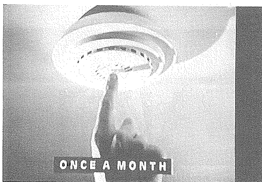
煙感知器の点検方法の映像 (ITN から)
