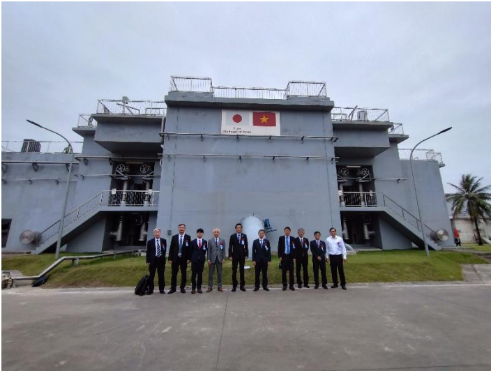
Installation « U-BCF » à Haiphong
