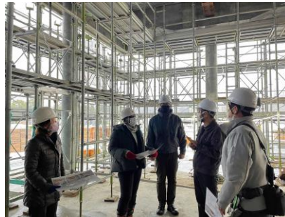
県立美術館の建築現場視察
