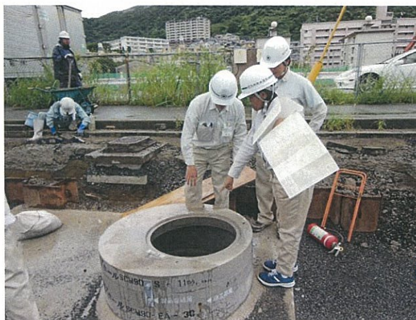
パイプラインの取り替えの視察
