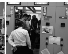
薬注設備点検実習
