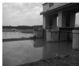
灌漑（かんがい）ダム
