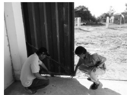
原料搬入用の入口扉
