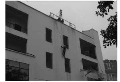
その後、梯子クレーンを活用し救助員を地上に救出している状況
