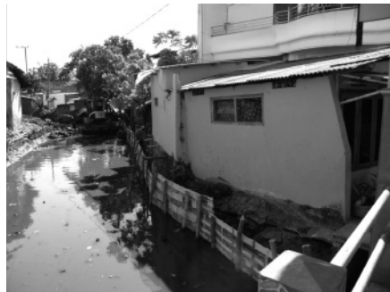
(バキス通り) 堆積物・沈殿物の除去作業状況（＝左奥）と護岸（国有地）上の不法占拠住宅等（＝左右岸）。
