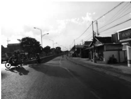
(バンユウリプ通り) 旧農業用水路を、浸水対策用に転用した、整備後の排水管渠等の状況（＝左側上段部）。
