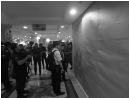
ファイヤーカーテン作動状況の確認 (ブルネイでは最近になって高層の建物が増え始めているが、防火のための区画をもっと考慮すべきではないだろうか。)
