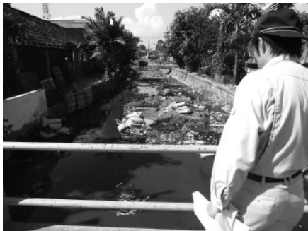
(バキス通り) 排水路・河川等の現地視察と説明提案等の状況。
