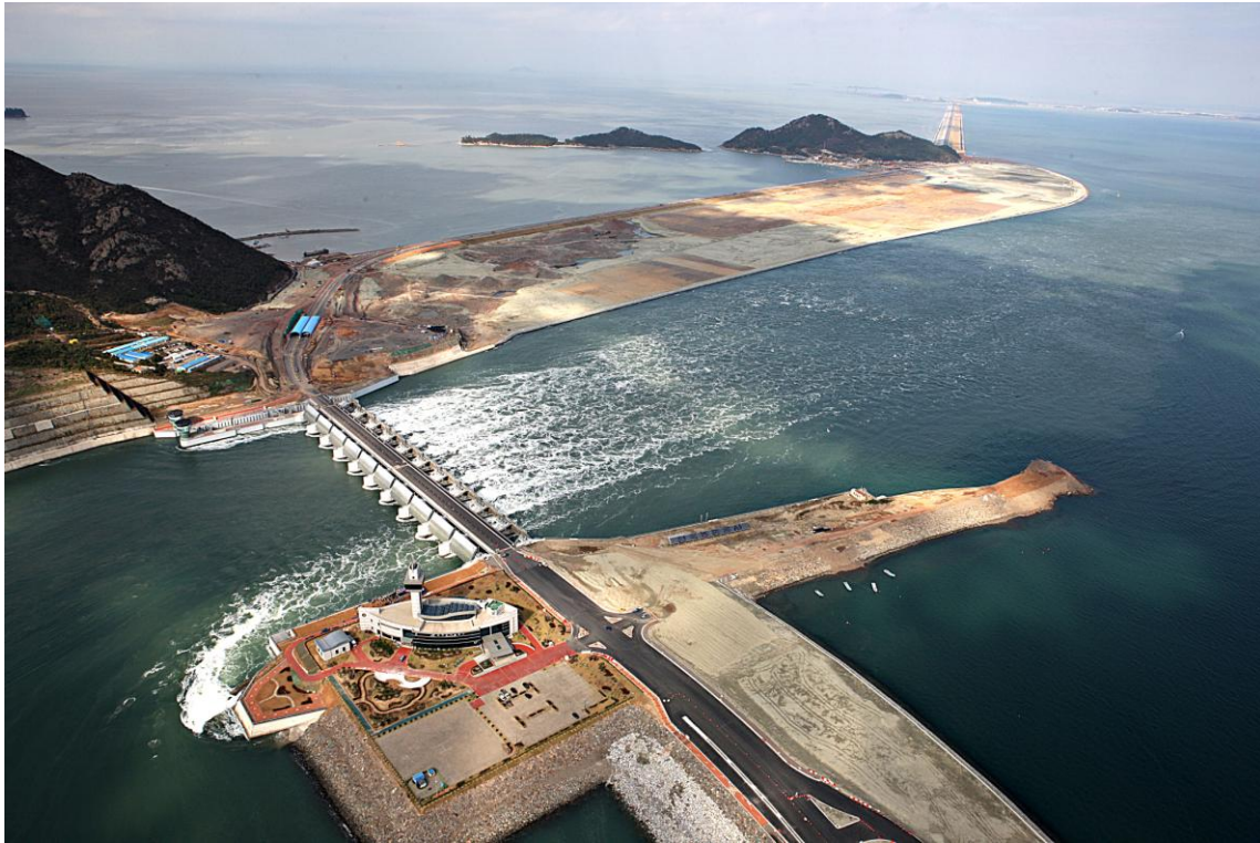
完成した世界最長の防潮堤。画像向かって左が海側。右が干拓予定地。
