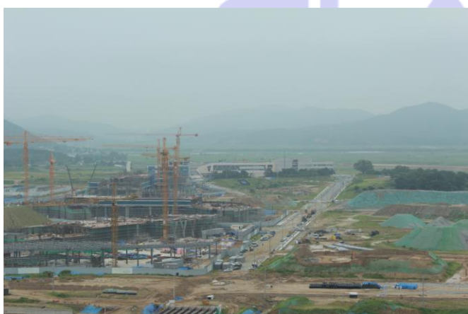
【2011年7月現在の建設中の政府庁舎の様子】
