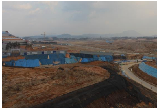
(内浦) 新都市建設現場
