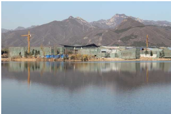
建設が進む会議場や宿泊棟の様子。現在は陸続きだが、計画によれば、この周辺自体も開催時には周りに水を張り巡らせて一つの島（核心島）となる模様。
