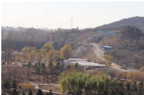
会場周辺部も整備が進む。上の写真は、会場へとつながるアクセス道路の建設現場。トンネル工事を進めている。
