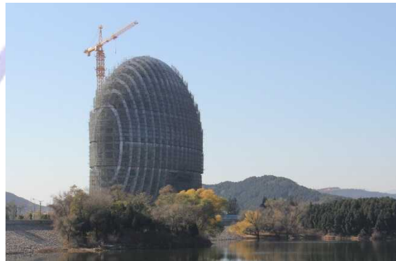
周辺に建設中の球体型をしたホテル
