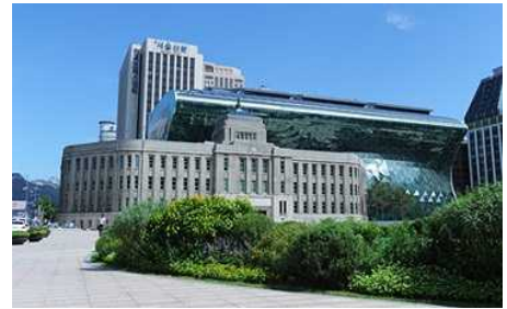
ソウル市新庁舎（中央奥）と旧庁舎（手前） （ソウル市ホームページより）
