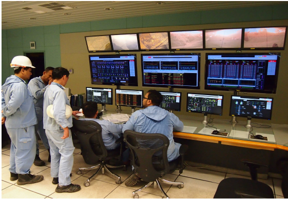
中央制御室の様子
