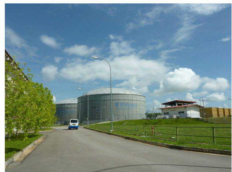
Newater 製造プラント
