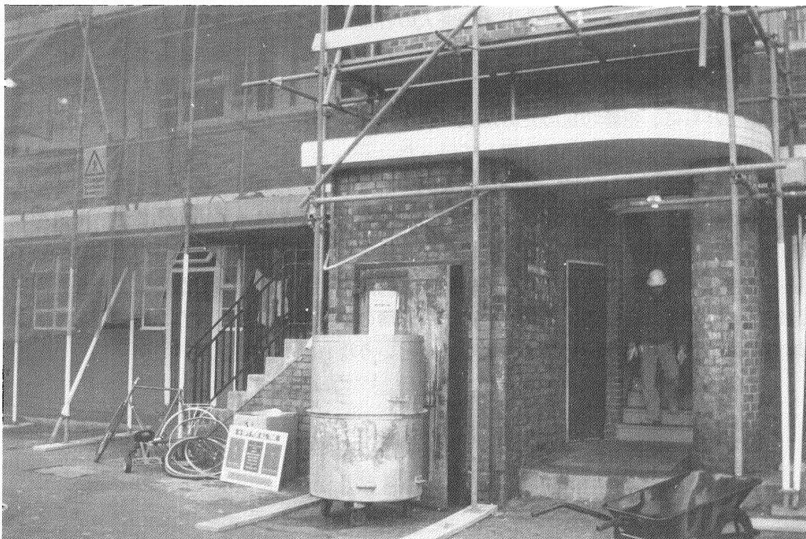
写真2 共通玄関設置後
