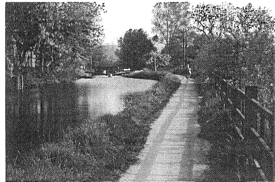
運河沿いの小道の整備
